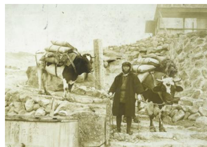
大涌谷での工事の様子(昭和初期) 提供:箱根温泉供給(株)
