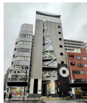
関係会社のプロトラストなどが入居していたビル
