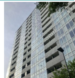
当社が入居していたビル
